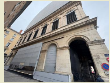
Accès monte-charge extérieur
