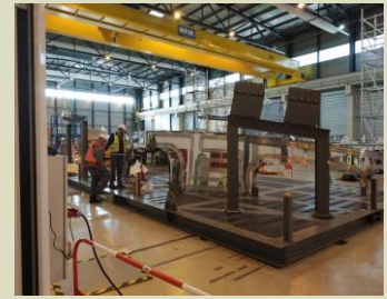
Réparation d'un échangeur
