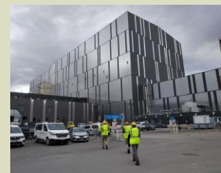
Hall de MONTAGE
