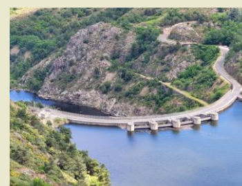
Barrage de Grangent
