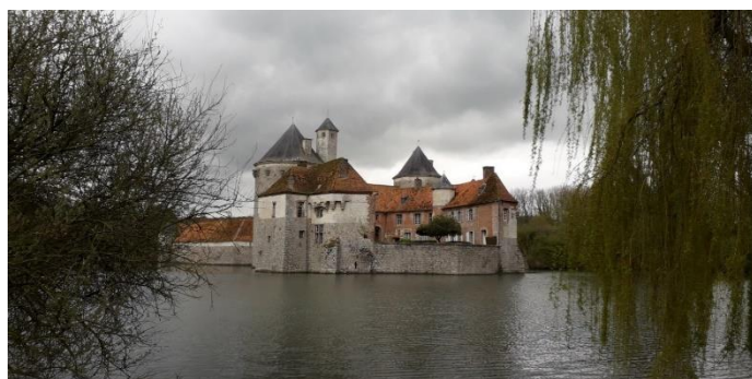
Vue des douves à l'arrière du château.
